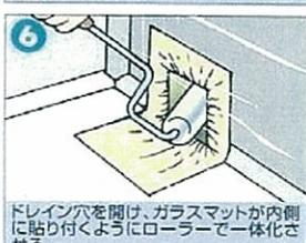
ドレイン穴を開け、ガラスマットが内側に貼り付くようにローラーで一体化させる。
