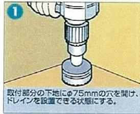
取付部分の下地にφ75mmの穴を開け、ドレインを設置できる状態にする。
